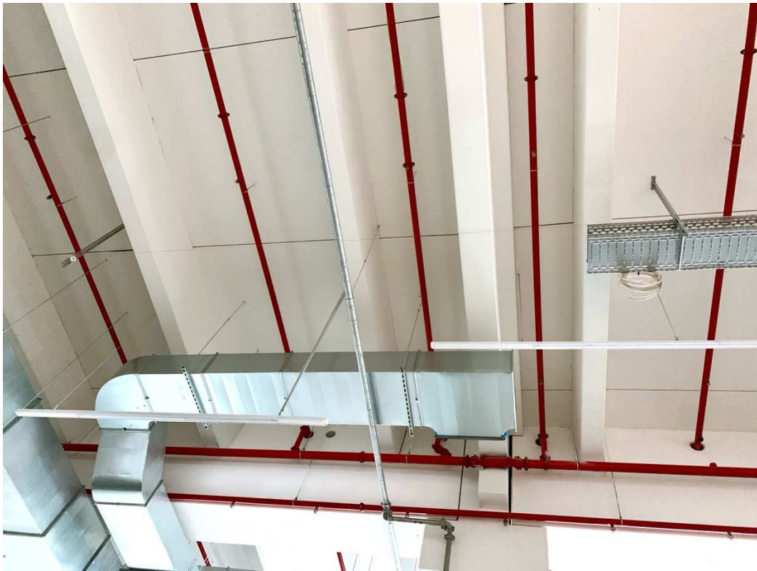
Abb. A1.28 Fertig gebohrte und montierte TGA-Installation unter der Decke nach Abschluss der Bohr- und Montagearbeiten (eigene Aufnahme).
