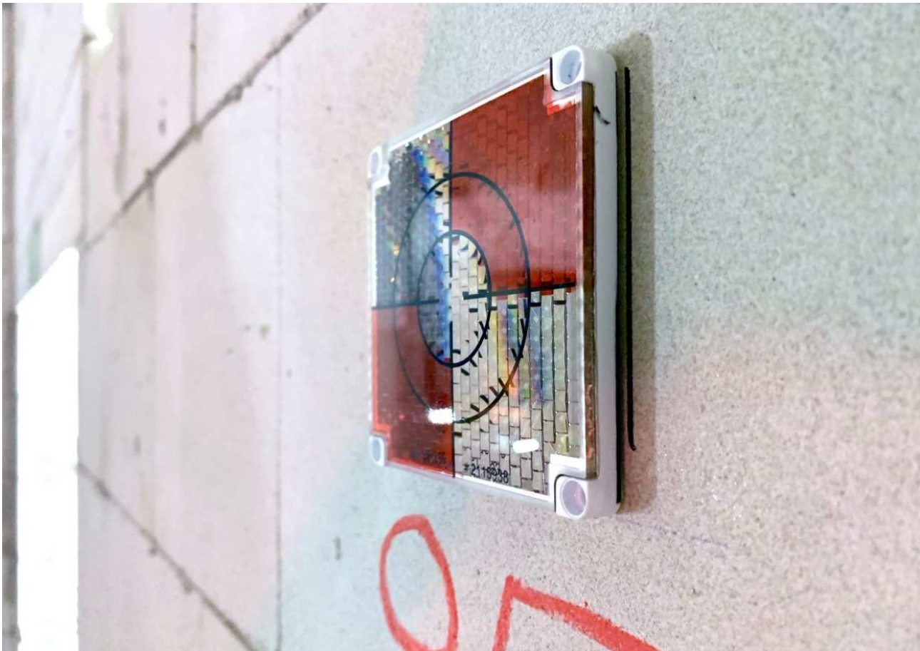
Abb. A1.14 An der Rohbauwand auf der Baustelle angebrachte Reflektormarke zur Referenzierung der PLT-Station im Arbeitsbereich des Jaibots (eigene Aufnahme).
