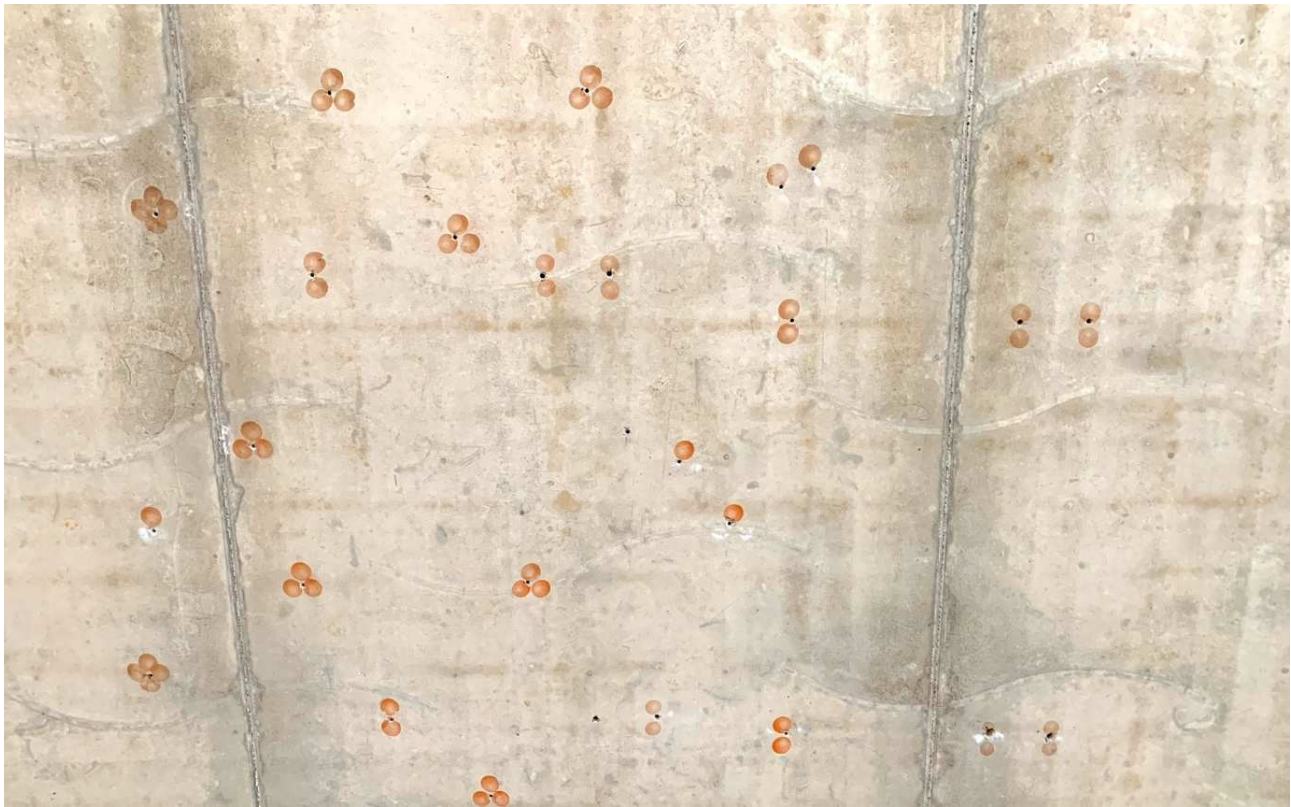
Abb. A1.10 Markierte Bohrlöcher an einer Betondecke mit unterschiedlichen Markierungsmustern zur Unterscheidung der jeweiligen Gewerke (eigene Aufnahme).
