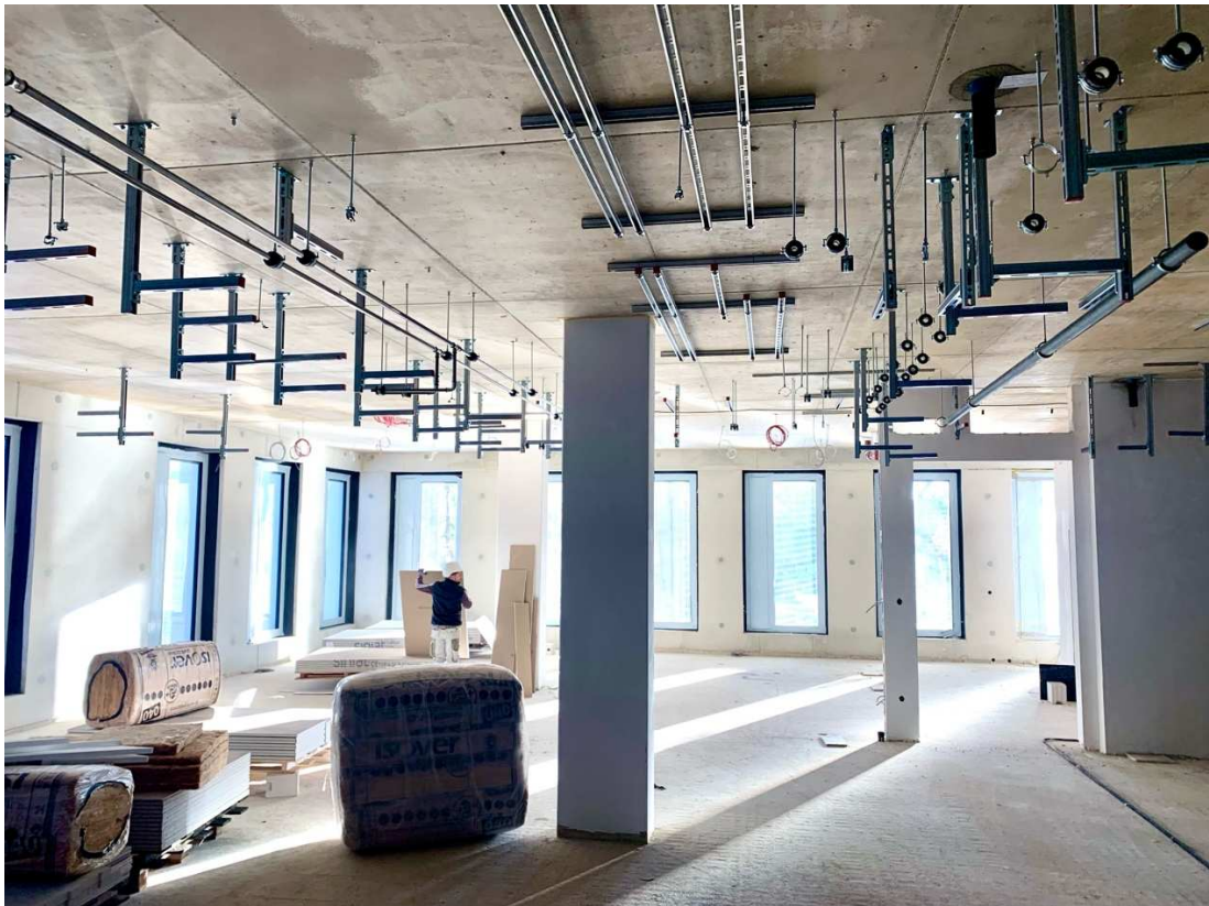
Abb. A1.32 Fertig gebohrte und montierte TGA-Installation unter der Decke nach Abschluss der Bohr- und Montagearbeiten aus der gleichen Perspektive wie in Abb. A1.31 (eigene Aufnahme).
