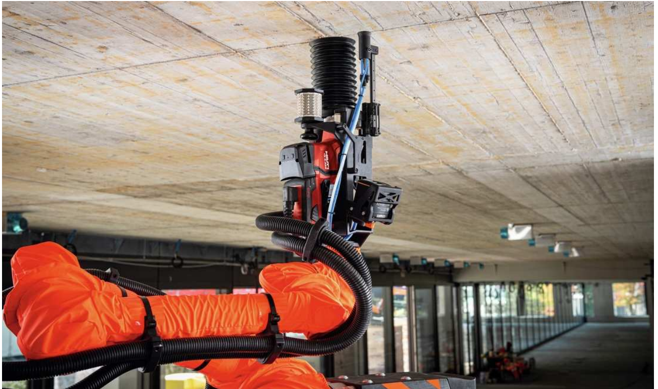
Abb. A1.8 Bohrarm des Jaibots während einer Deckenbohrung, ummantelt mit einer orangenen Schutzhülle und mit Bohrkopf am Ende (Hilti Deutschland AG 2022).
