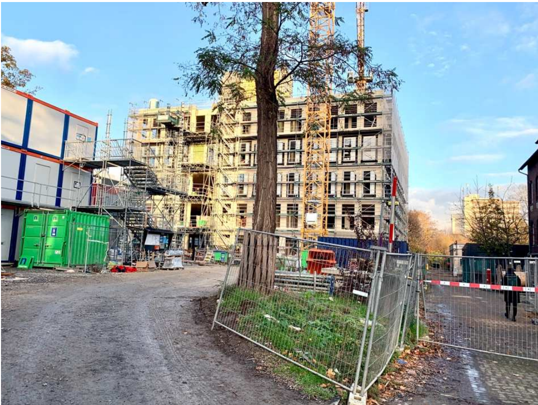
Abb. A1.29 Außenansicht des Neubaus für das Zentrum für Stoffwechselforschung an der Uniklinik Köln. Dieses Bauprojekt dient als Beispiel zur Erfassung und Analyse des semi-autonomen Bohrprozesses mit dem Jaibot (eigene Aufnahme).
