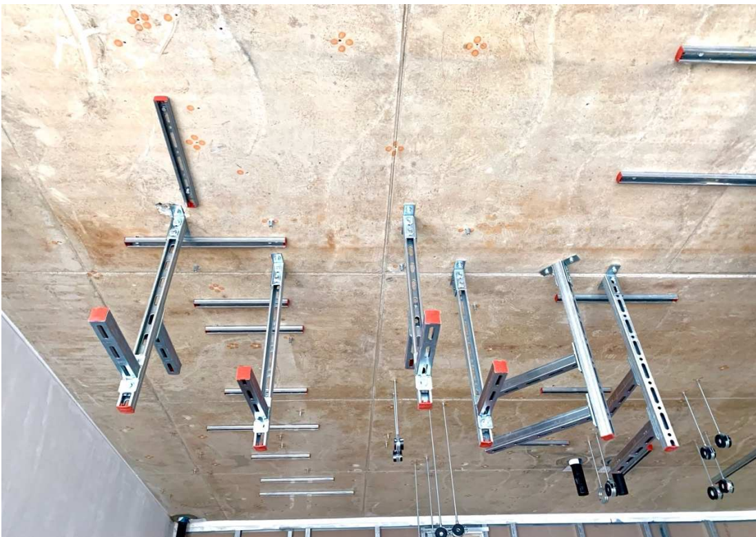
Abb. A1.33 Nahaufnahme der fertig montierten TGA-Installation mit sichtbaren Bohrlöchern und Markierungen, die durch den Jaibot erstellt wurden (eigene Aufnahme).
