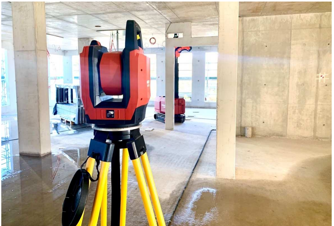
Abb. A1.13 PLT-Station (PT 300) auf einem Stativ mit Jaibot im Hintergrund und sichtbarem grünen Laserstrahl auf dem Prisma (eigene Aufnahme).
