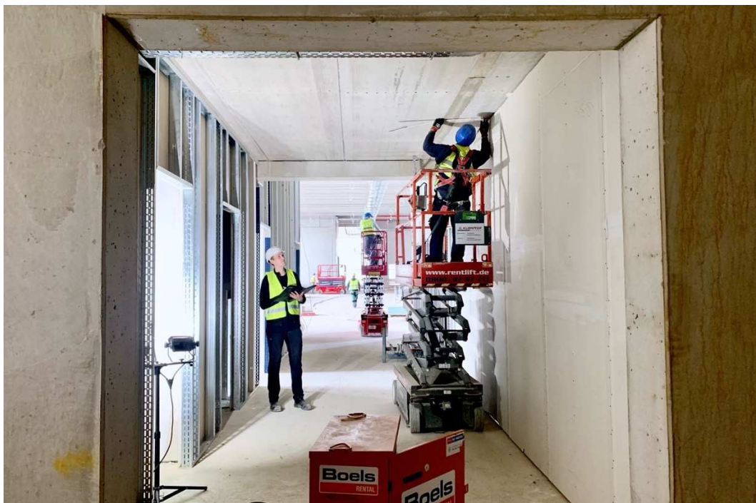
Abb. A1.27 Durchführung der Zeitaufnahme: Der Beobachter verfolgt den Mitarbeiter, der auf einer Scherensarbeitsbühne die Bohrlöcher mithilfe eines Gliedermaßstabs einmisst (eigene Aufnahme).
