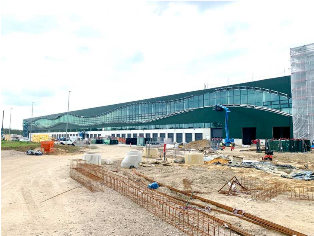
Abb. A1.24 Außenansicht des Neubaus einer Logistikhalle im Industriepark „Große Heide Wulfen“ in Dorsten. Dieses Bauprojekt dient als Beispiel zur Aufnahme und Analyse des manuellen Bohrprozesses (eigene Aufnahme).
